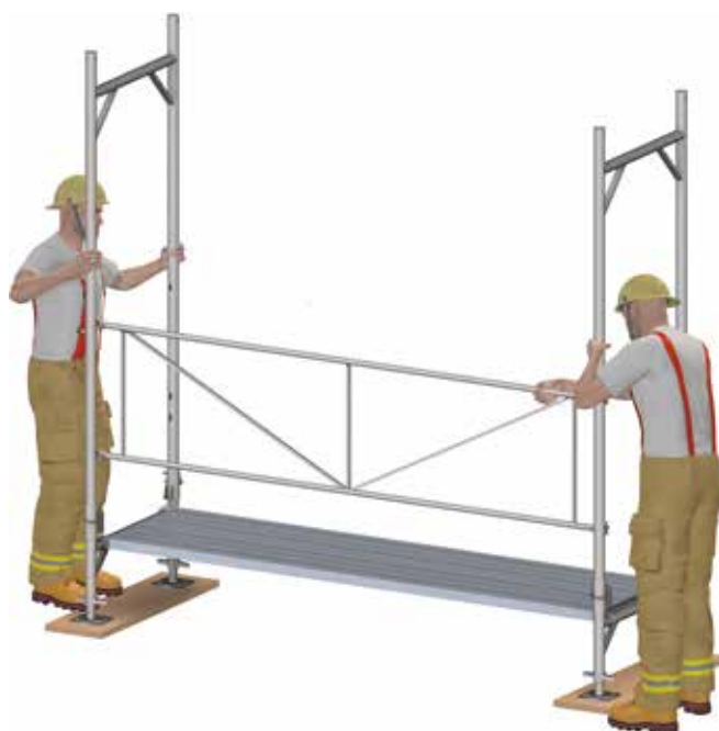
Figure 3: Montage du premier champ d'échafaudage.
