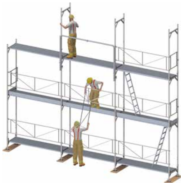
Figure 15: Montage du niveau d'échafaudage dans le champ de montée avec protection par le MSG.
