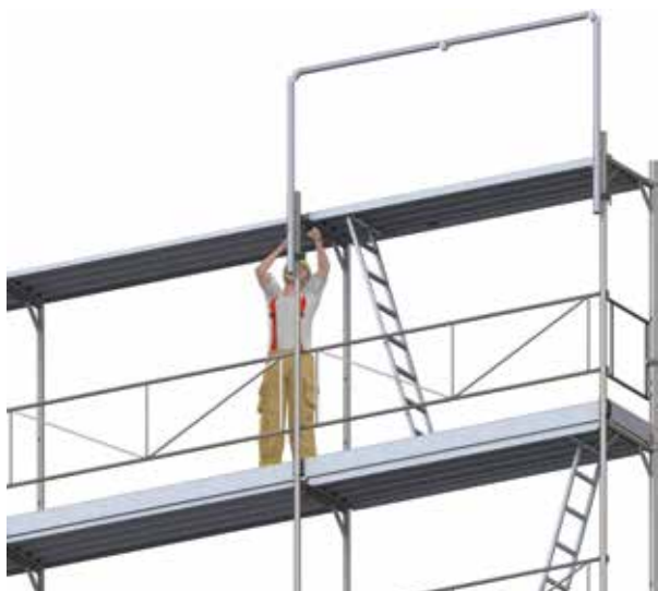
Figure 14: Montage du MSG dans le champ de montée depuis le niveau sécurisé.
